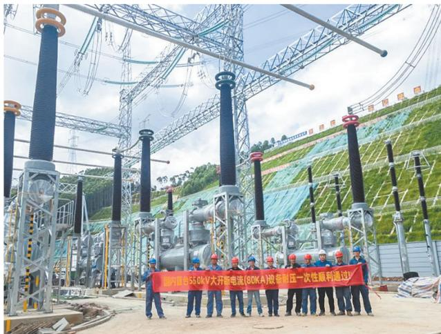
平高集团、平高电气自主研发的国内首台压气式550千伏80千安HGIS设备耐压一次性通过,投入运行以来状态良好。
