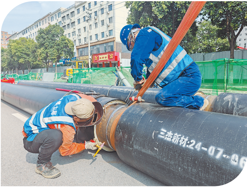
供热工程加紧施工
