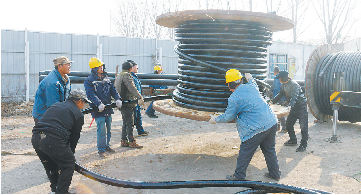
10千伏线路安装工程
