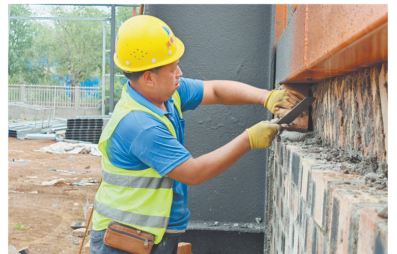
鲁山县旅游装备产业园加紧建设
