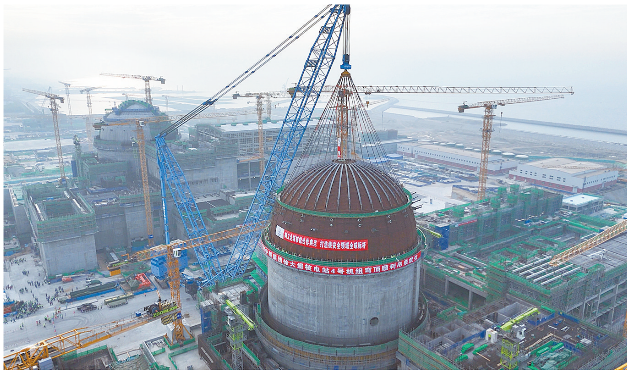
徐大堡核电站4号机组穹顶吊装就位
