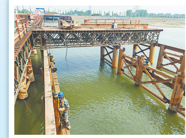
△施工平台焊接作业
