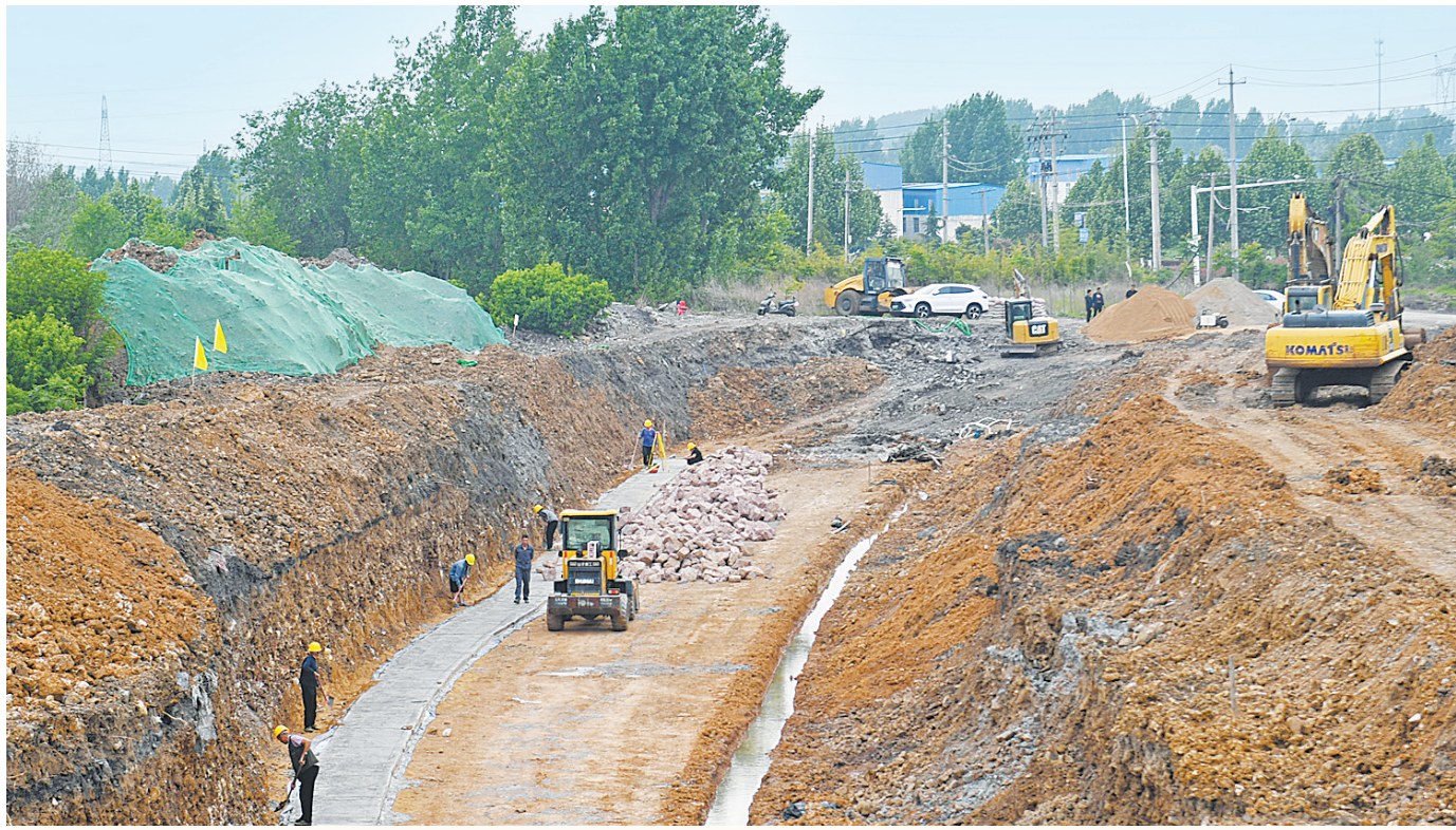
4月24日,施工人员在平郊快速通道东侧开挖祥云河河道。
