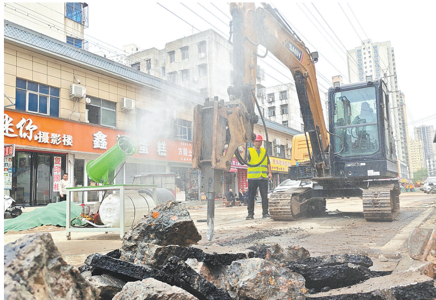
4月15日,工人操控机械在现场施工。
