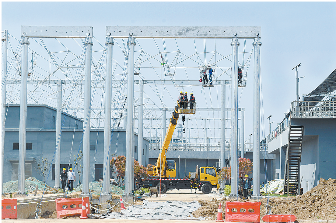
建设分布式光伏项目
