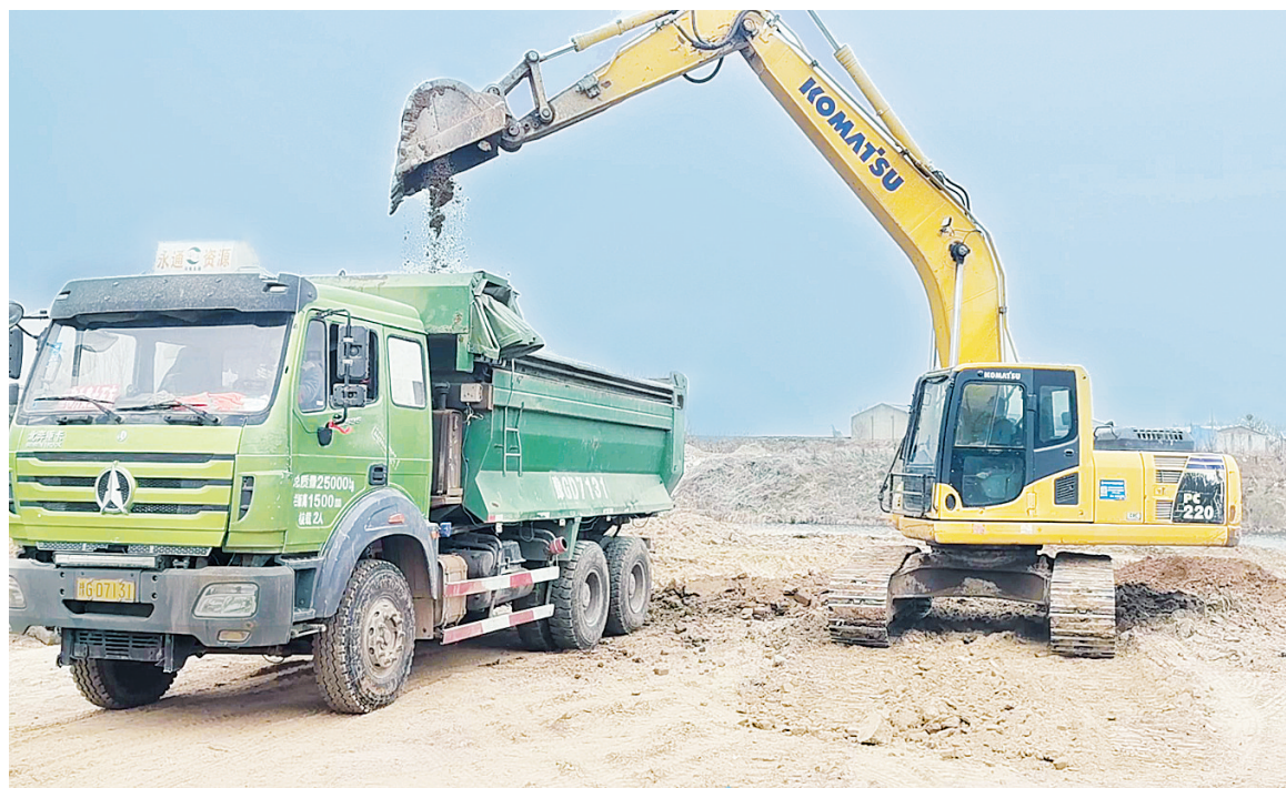
三月十七日,在湛河区北渡街道油坊头村沙河槽取土工地,挖掘机正向卡车上装土,用于回填堤顶路。本报记者 宋昱 摄
