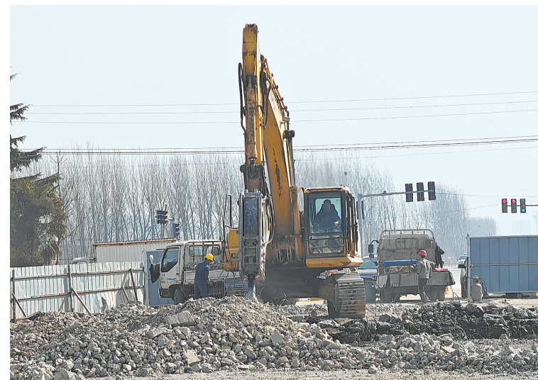
平鲁快速通道加紧施工
