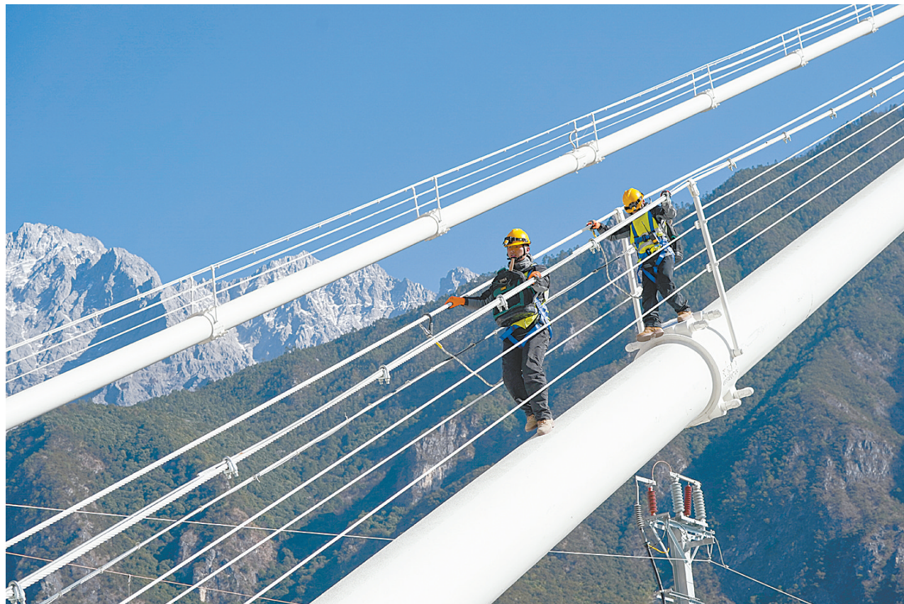
“高空舞者”守护虎跳峡金沙江铁路大桥
