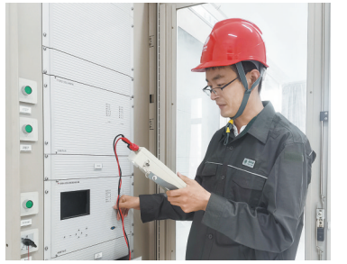
马文恒为线路保护采样回路做极性检测
