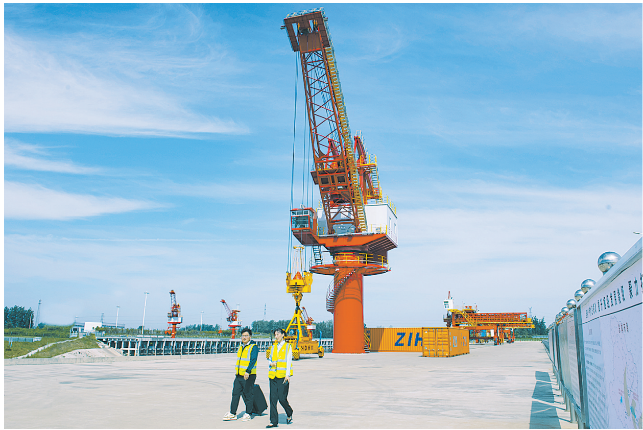
沙河复航项目完工(资料图片)
