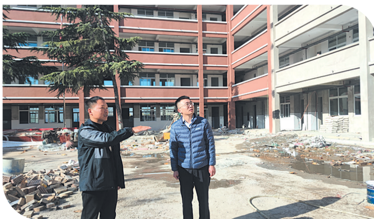
宋亚斌(左)给小微团队负责人介绍综合楼施工情况
