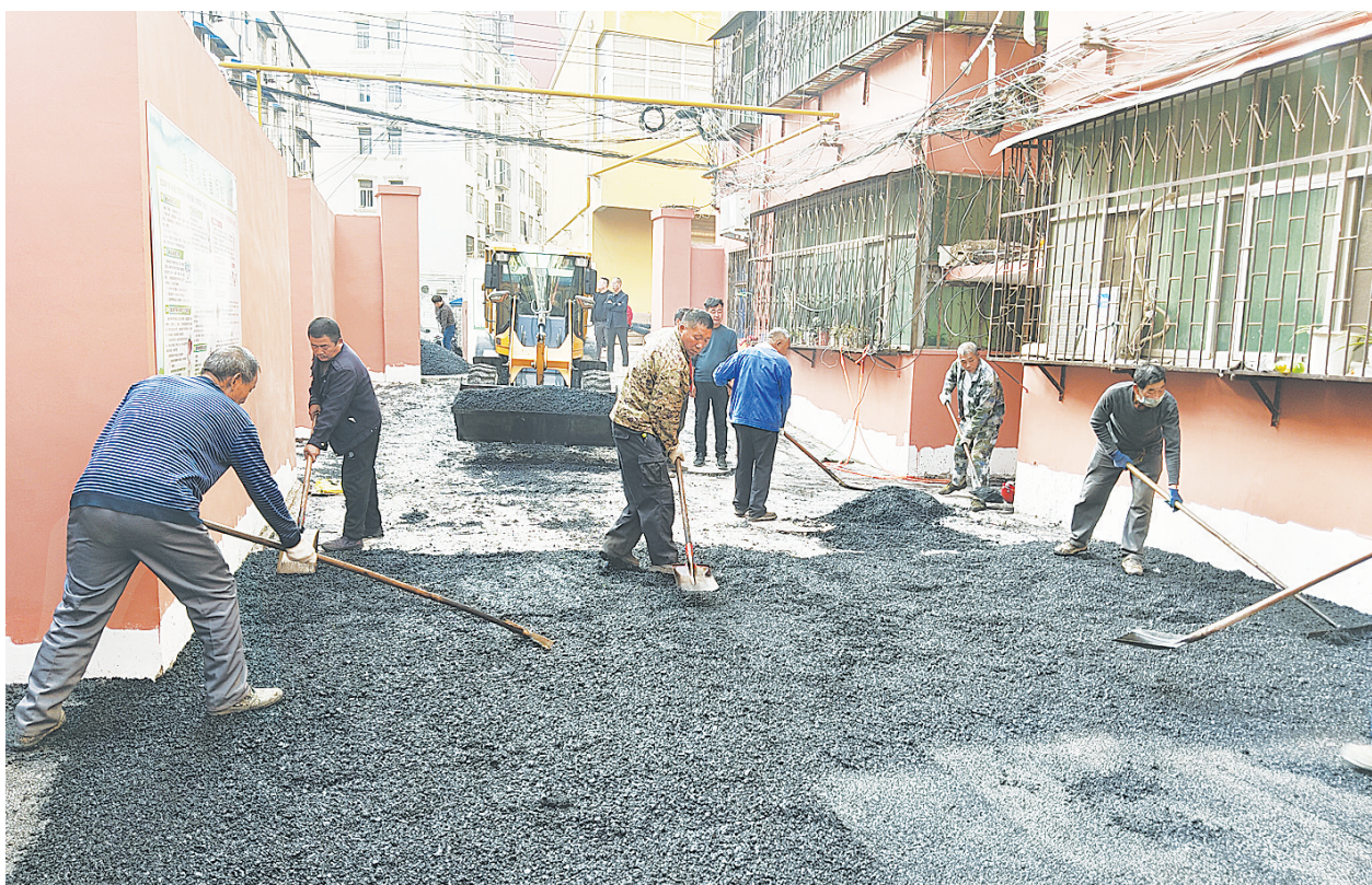
11月22日,施工人员在九龙街道华旗小区施工。
