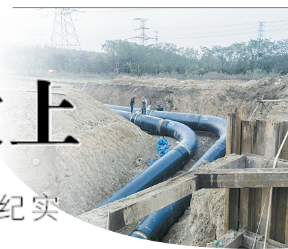
管线施工现场
