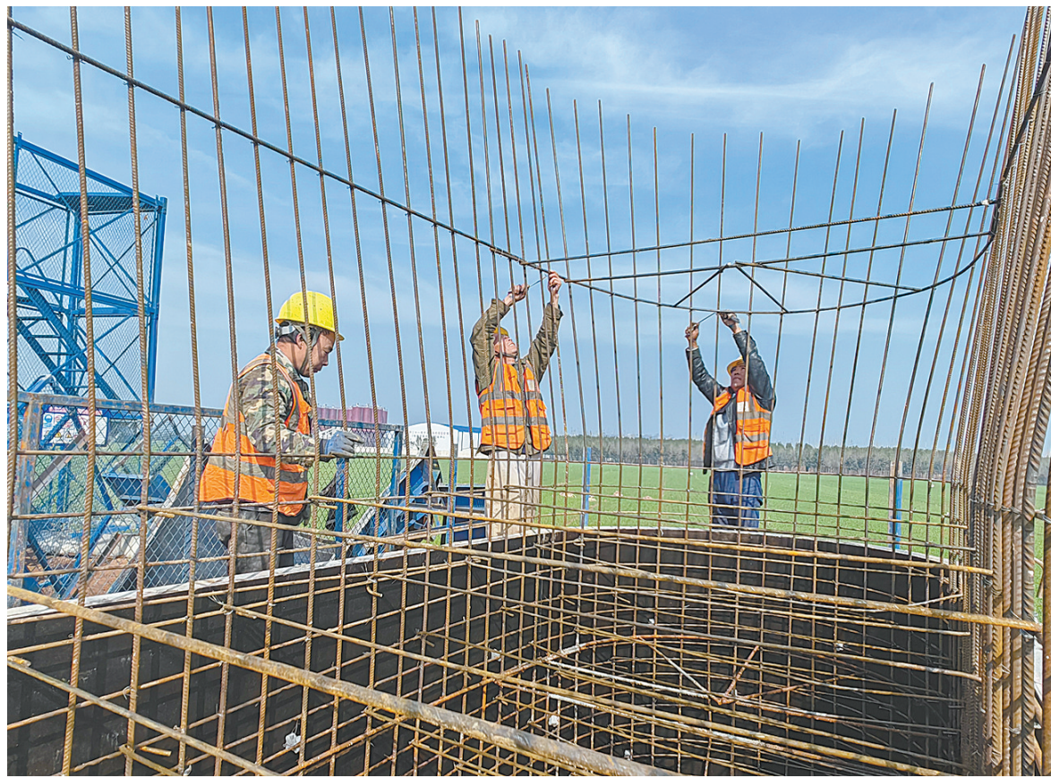
平漯周高铁有序建设中
