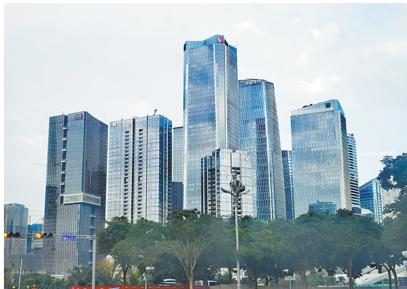
位于深圳市南山区粤海街道科技园社区的讯美科技广场 本报记者 禹珂 摄
