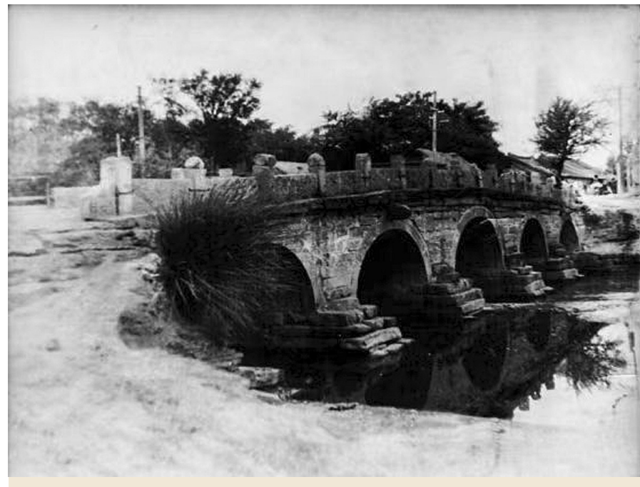
上图：大石桥新貌 左图：大石桥老照片（资料图） 图片由宝丰县石桥镇宣传办提供
