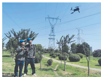
7月8日,输电运检中心工作人员郭晓飞和同事们完成了尊平线、滹计线线路交叉跨越点等重点部位的巡视。
