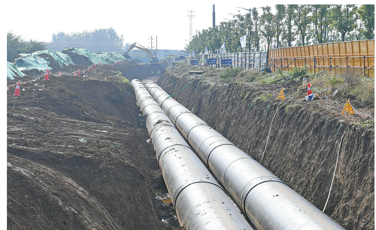
加紧铺设集中供热管网
