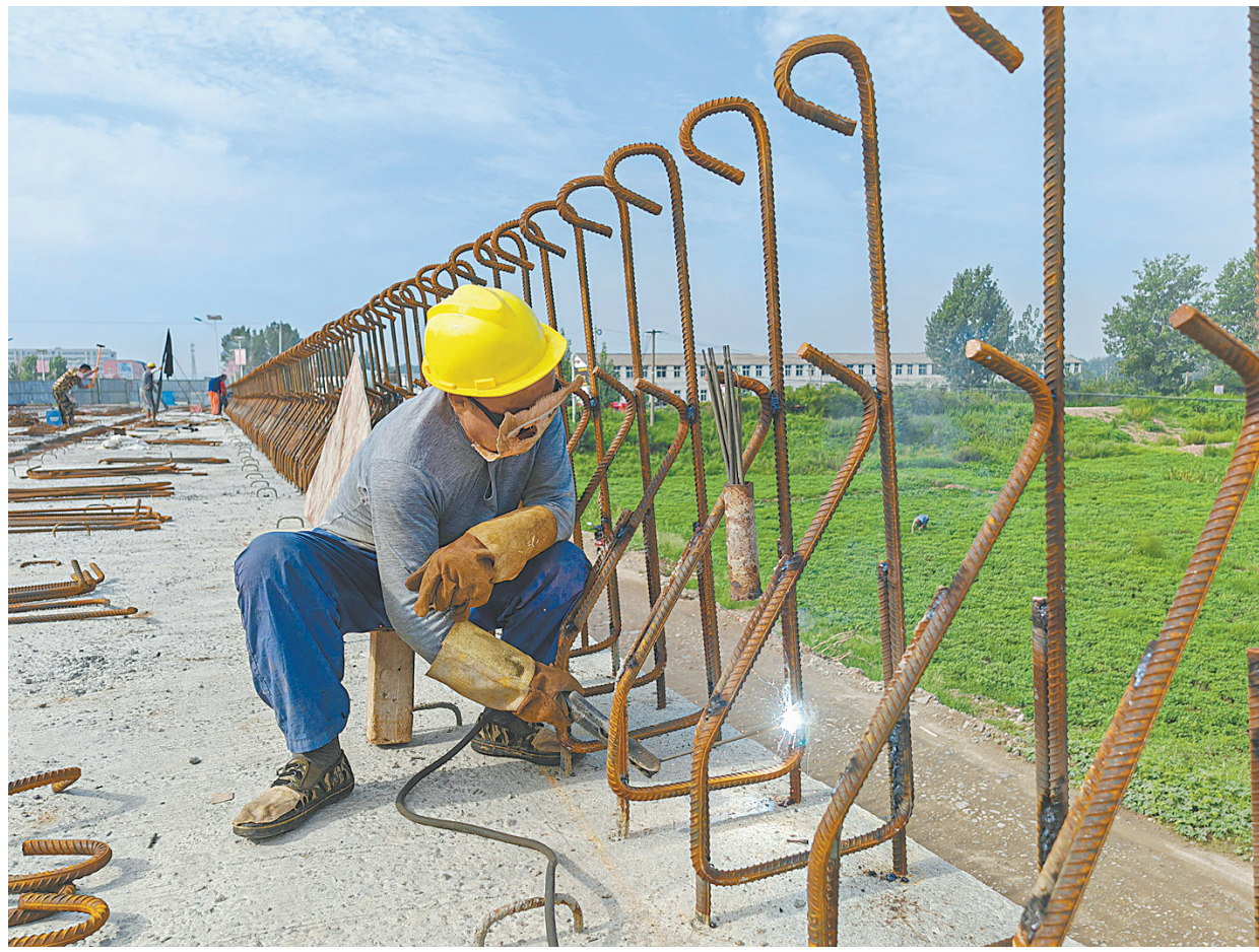
维修加固工程即将完工
