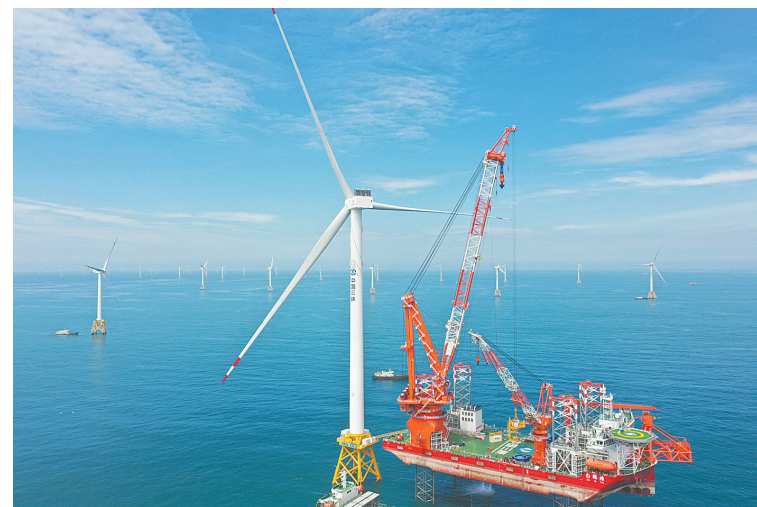
全球首台16兆瓦海上风电机组在福建成功吊装
