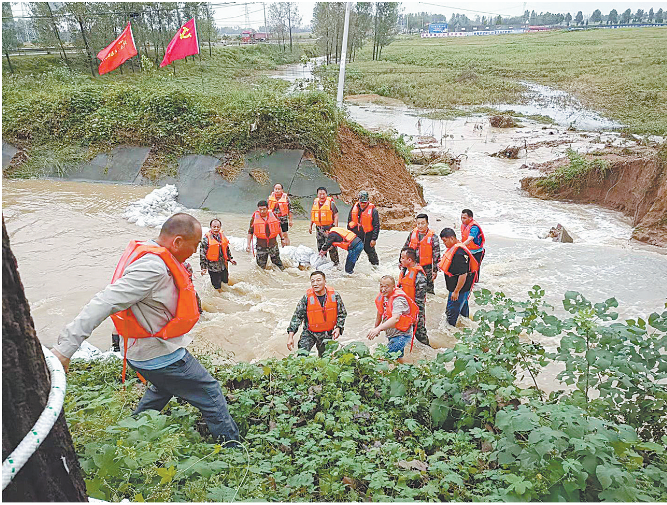
叶县民兵综合应急连在抗洪抢险一线。
