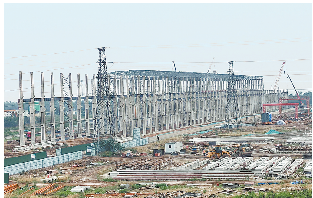
河南领创碳材料产业园项目加紧推进
