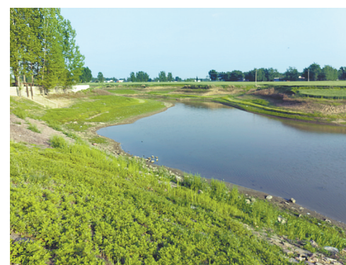
叶陵坝体一角 本报记者 杨沛洁 摄 (杨沛洁)
