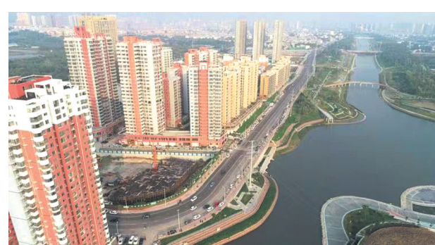
湛河北路西延工程完善了城市路网
