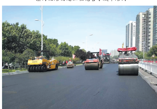
文明施工的湛河北路西延工程
