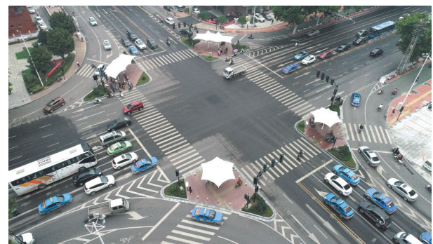
优化改造后的中兴路与建设路交叉口畅通无阻
