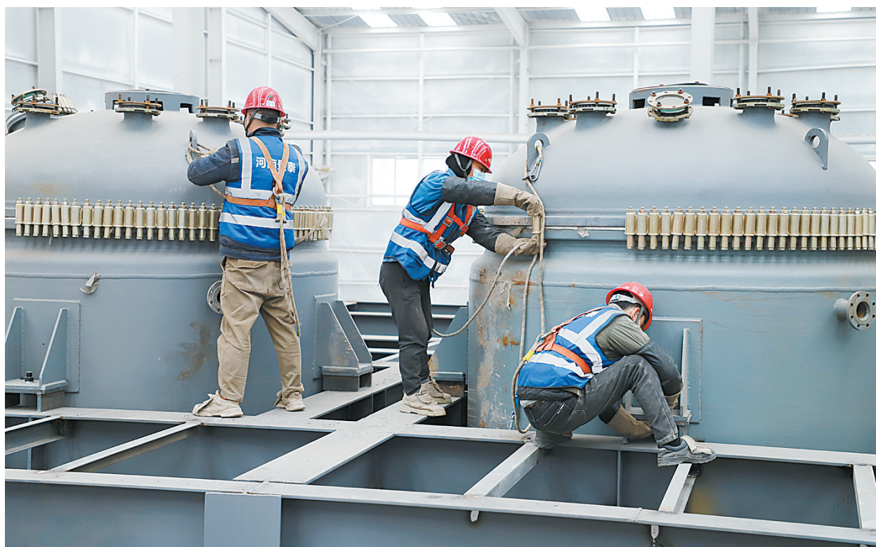
近日,技术人员在车间加紧安装调试设备。
