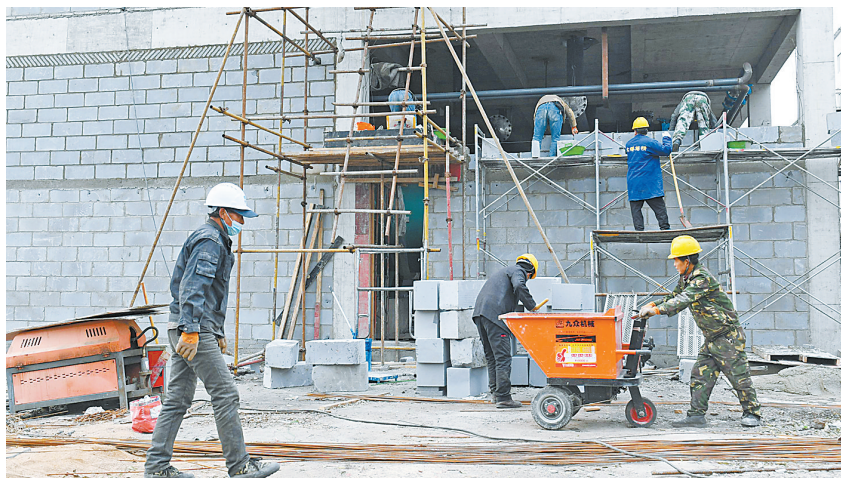
12月28日,施工人员在新华区新街街道与中国平煤神马五矿六矿联合实施的集中供暖热源改造工程换热首站施工现场加紧施工。
