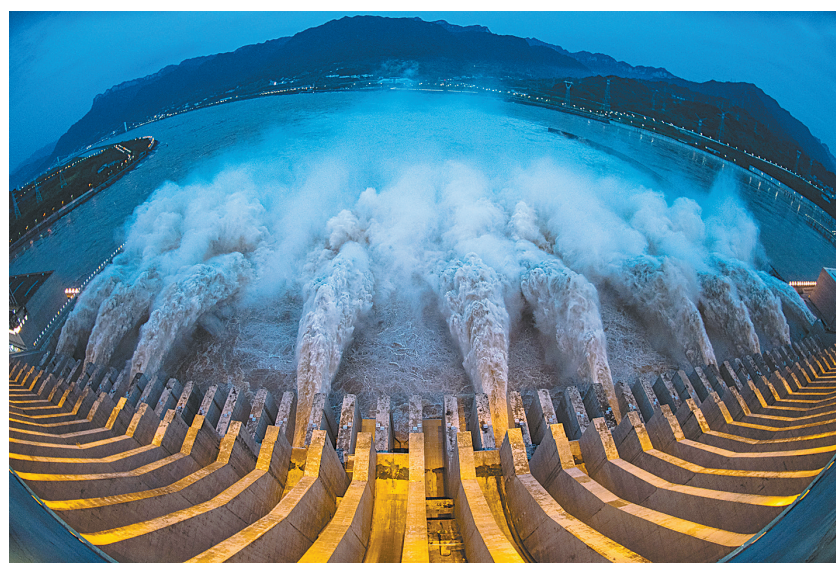
这是2020年8月19日拍摄的长江三峡水利枢纽工程开启泄洪深孔泄洪（无人机照片）。 新华社记者 肖艺九 摄
