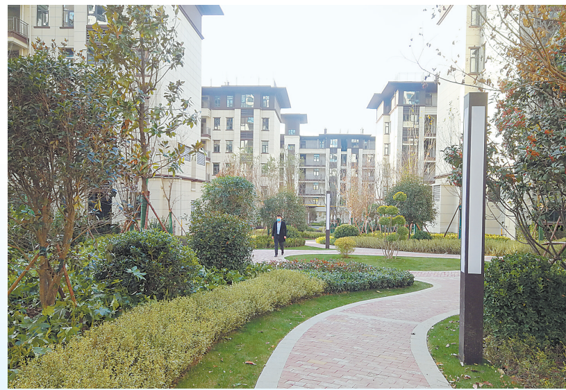
建成交付的茂庭澜山府项目
