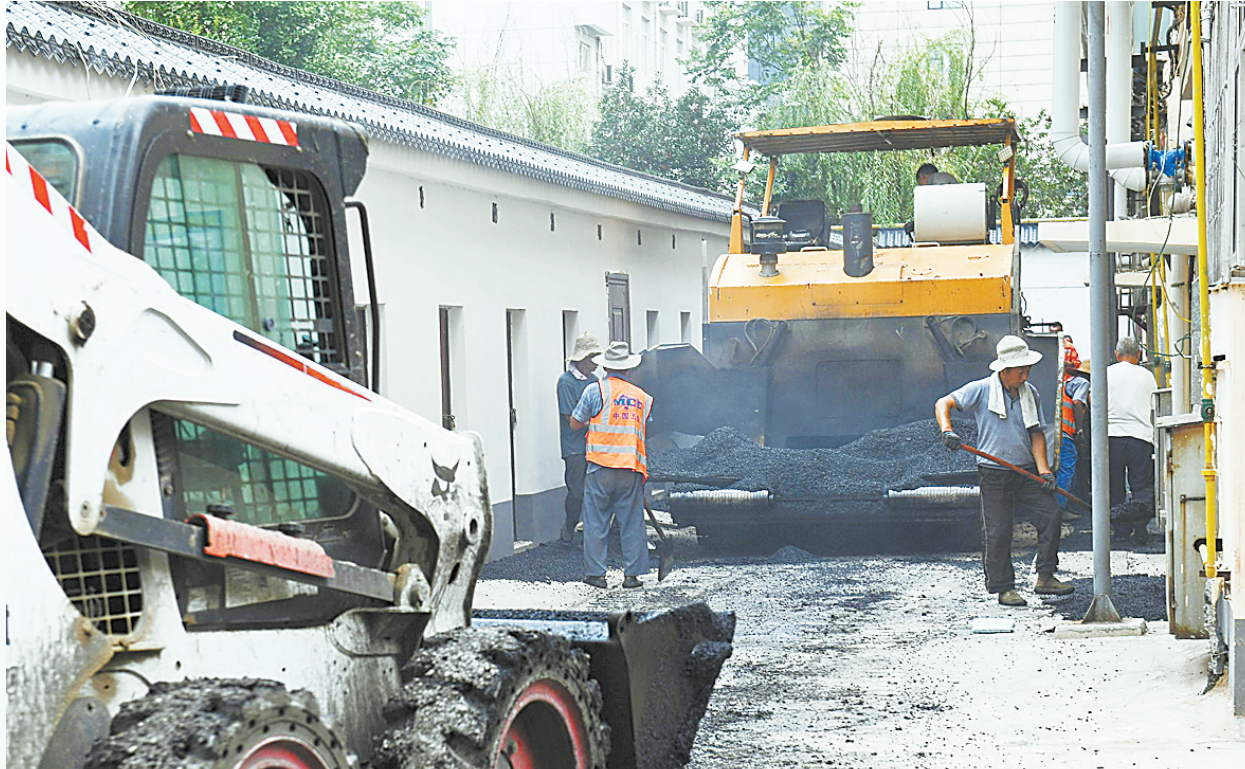
改造老旧小区 8月25日,施工人员在市区建设路西段268号院内铺设沥青路面。该家属院始建于上世纪80年代,基础设施年久失修。为给居民提供一个更加良好的生活环境,新华区曙光街道办事处对该家属院排水、道路、绿化、线路等基础设施进行了全面改造,目前已进入最后的细节完善阶段。 本报记者 牛智广 摄
