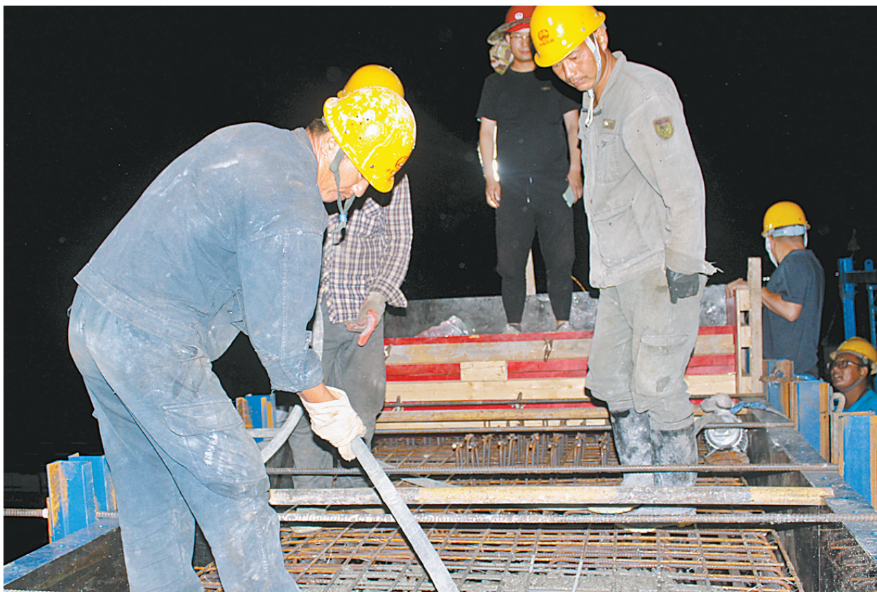
焦唐高速汝方段首片盖梁顺利浇筑
