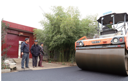
升级改造农村道路
