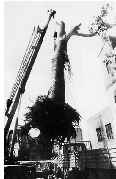
鹰城广场初建时，施工人员进行吊车上转移树木。市园林绿化中心供图
