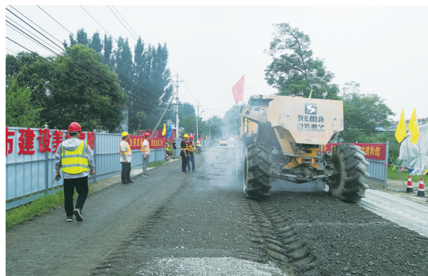
苗张路路面再生施工现场
