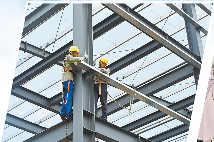
摩米创新科技园在加紧施工
