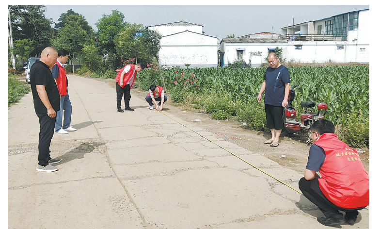
保障农村公路畅通
