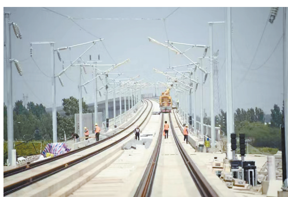
2019年7月11日,郑万铁路平顶山段电气化施工顺利完工。
