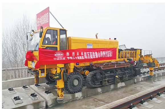
2019年1月15日,郑万铁路平顶山段铺轨全部完成。
