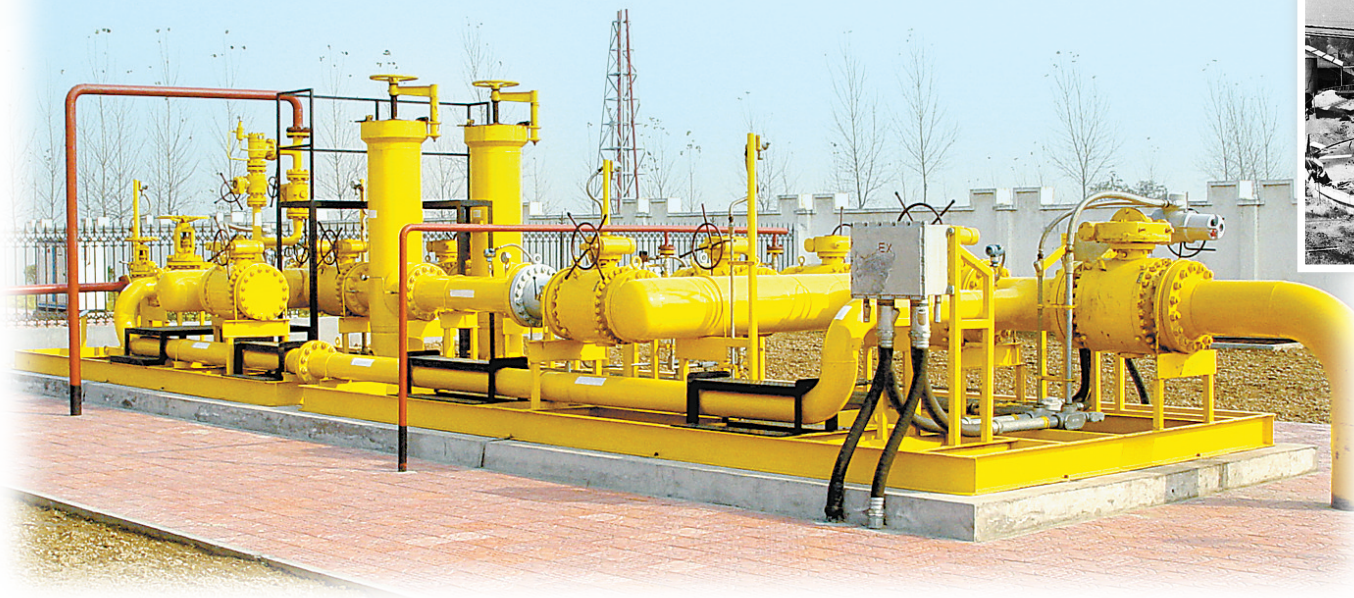
平顶山燃气公司新建成的天然气脱硫
