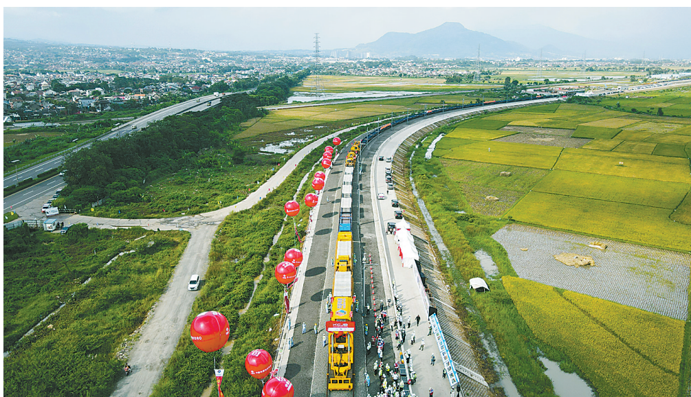
印尼雅万高铁动车走行线开始铺轨
