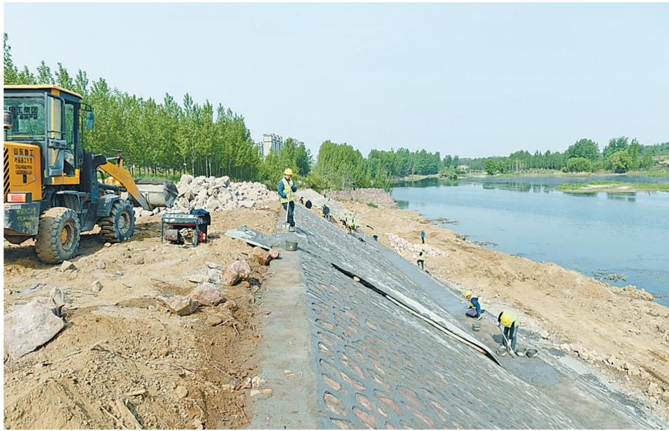
4月19日,施工人员在沙河叶县粪店镇叶寨村段堤防防护坡工程施工现场加紧施工。
