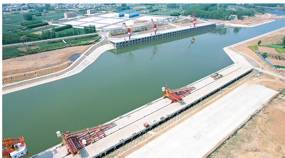
平顶山港两个港区的6台装卸设备安装完毕,可以满足多种类型货物的装卸需求。
