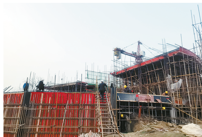
孤山寨民宿项目加紧施工
