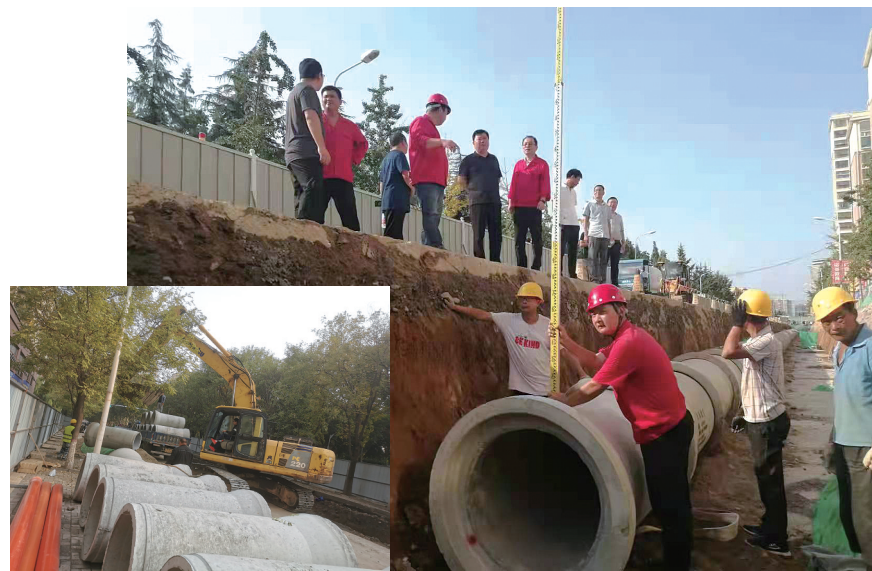
广场西街施工现场（小图由本报记者杨冲洁摄）
