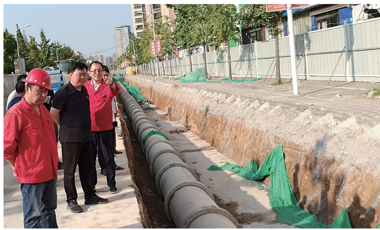
县住建局局长滕跃峰（左二）察看项目建设
