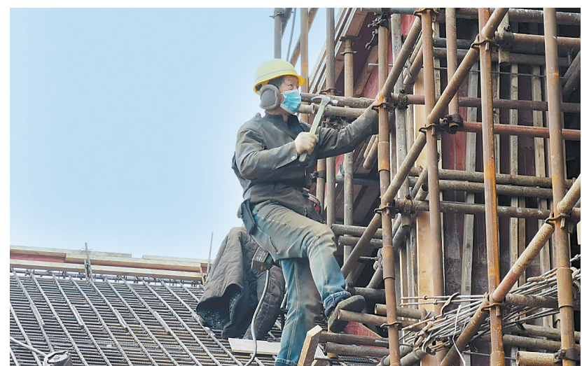
文旅项目加紧施工
