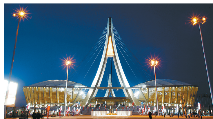
中国援建柬埔寨国家体育场项目正式启用
