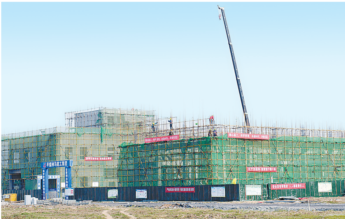
建设配套氩氮项目
