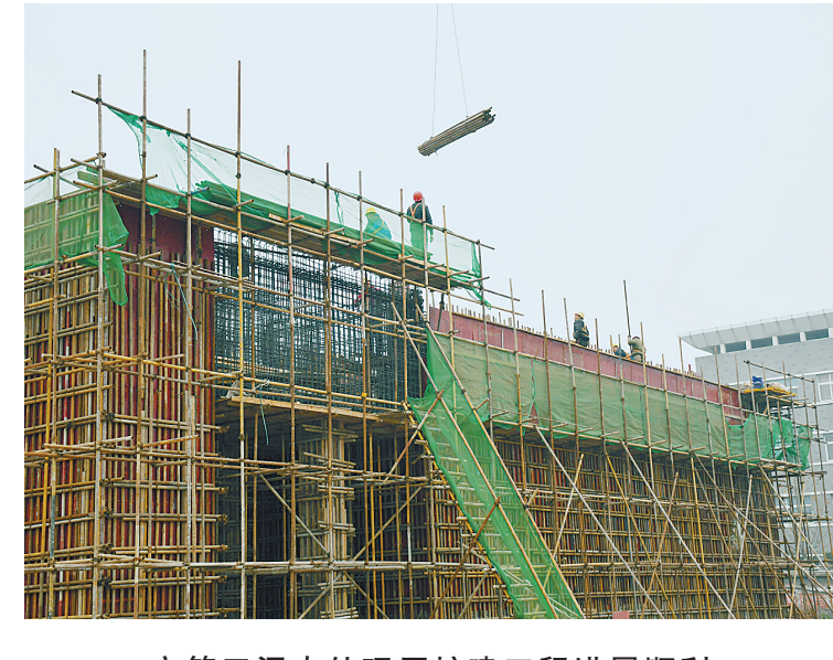
市第三污水处理厂扩建工程进展顺利
